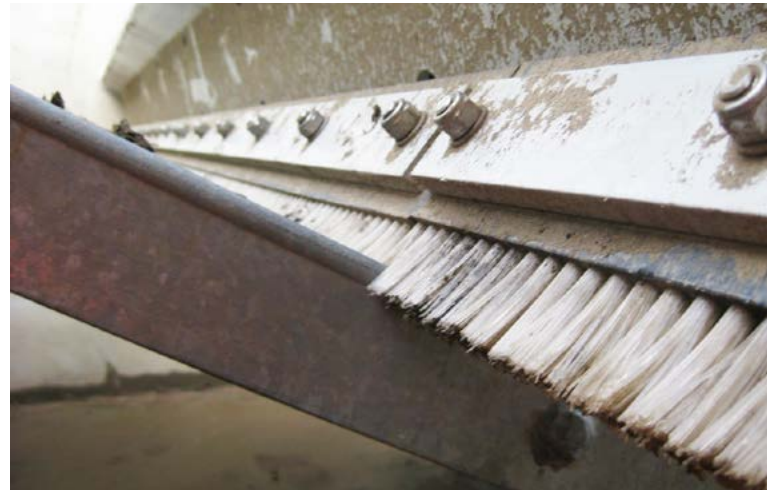
Reinigungsbürste eines Rechenreinigers
