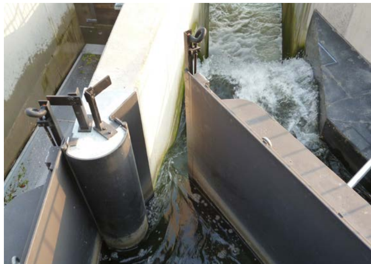
Diesen Abstiegsweg nehmen die abwandernden Fische hinter den Bypassöffnungen des Rechens, um zurück in die Sieg zu gelangen.
