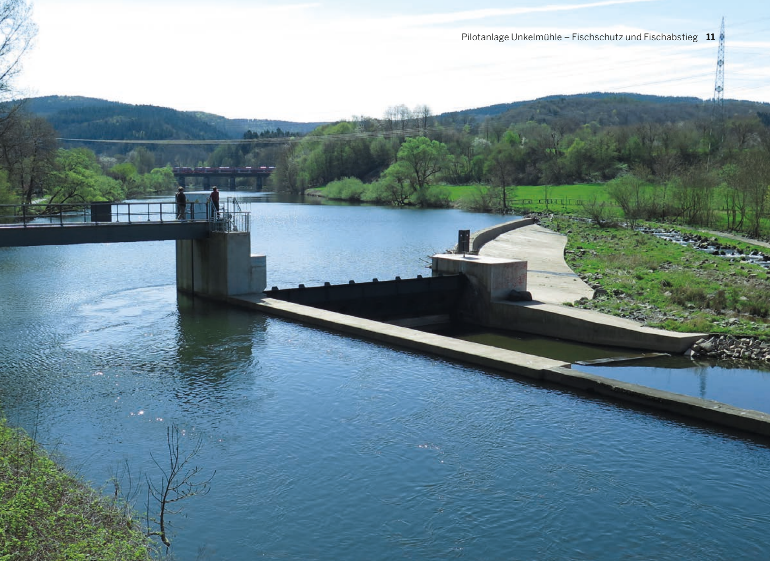
Querbauwerke mit Rückstau
