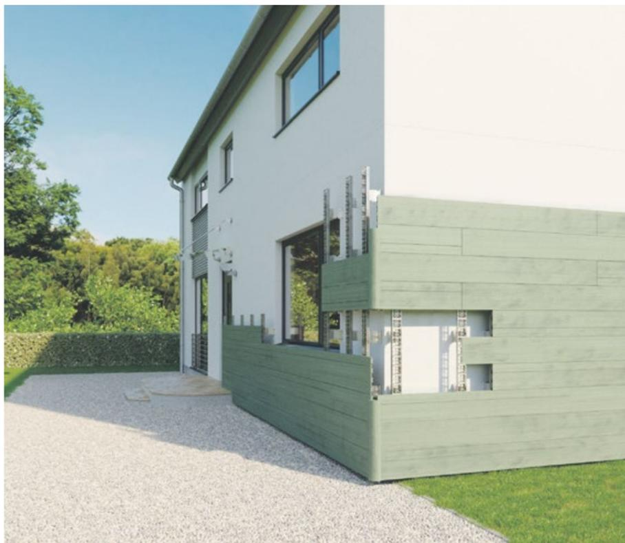
Dämmen und gleichzeitig die Optik des Eigenheims verschönern: Eine Holz-Faser-Fassade in hinterlüfteter Ausführung ermöglicht beides. Foto: djd/megawood.com
