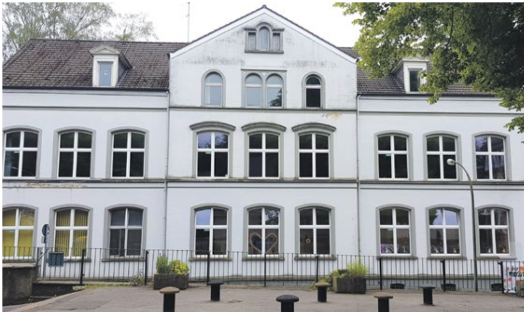
Das Gebäude der OGS an der Hardtstraße ist sanierungsbedürftig.
