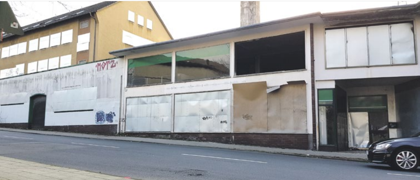
Noch auf der To-Do-Liste der BV Lennep: Der Abriss des leerstehenden Möbelhauses am Bahnhof. Foto: Segovia
