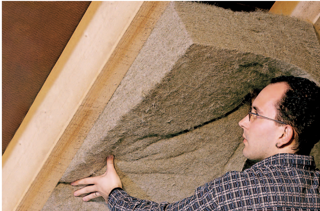
Materialien wie Holz, Hanf und Jute dämmen ähnlich gut wie Polystyrol, Glas- und Steinwolle.
