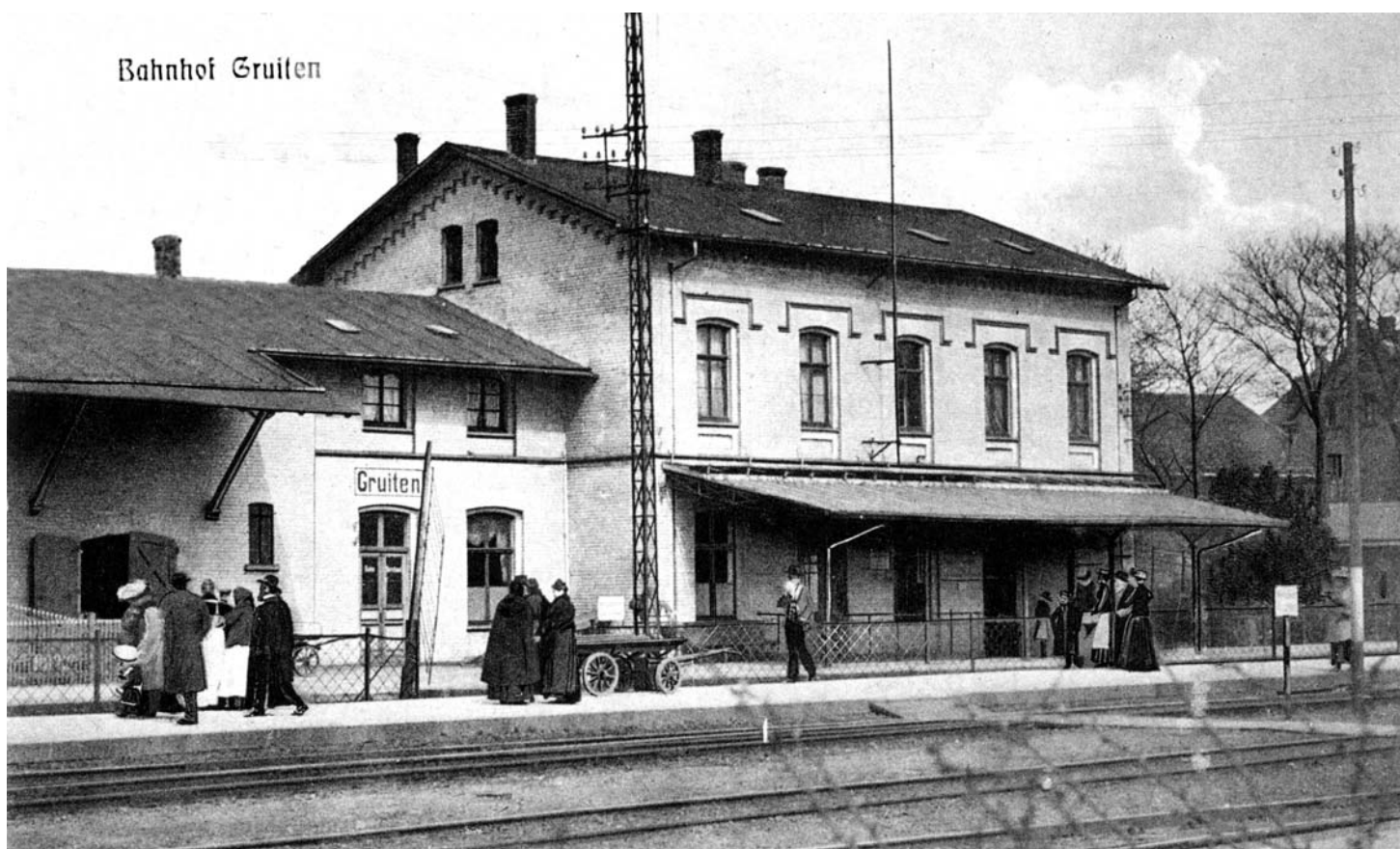
Immer noch Treffpunkt und nur behutsam verändert, das historische Bahnhofsgebäude.
