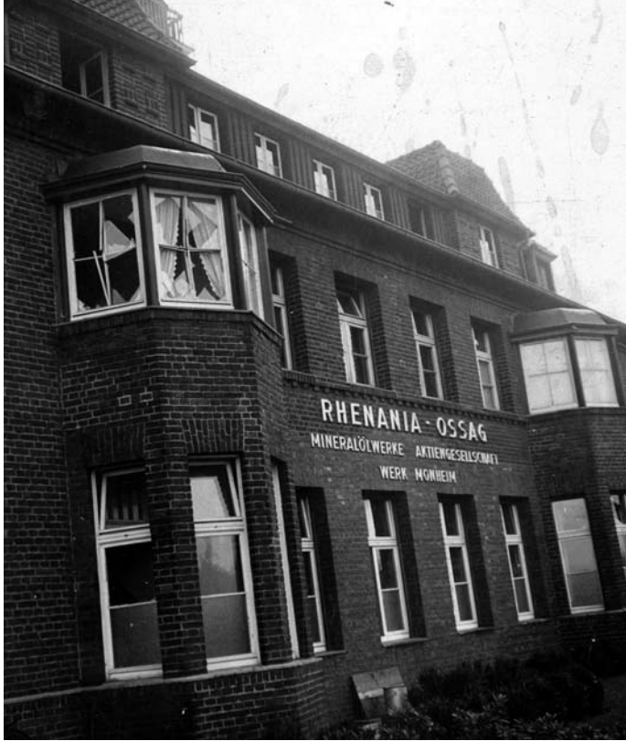
Beim Abwurf von Sprengbomben auf die Rhenania-Ossag-Mineralölwerke am 28. Juni 1940 wurde unter anderem das Verwaltungsgebäude beschädigt.
