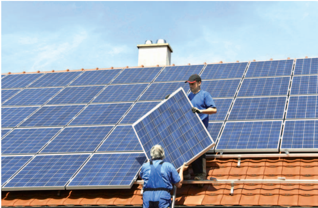
Eine Solaranlage wird installiert. Die meisten Deutschen befürworten Solartechnik.
