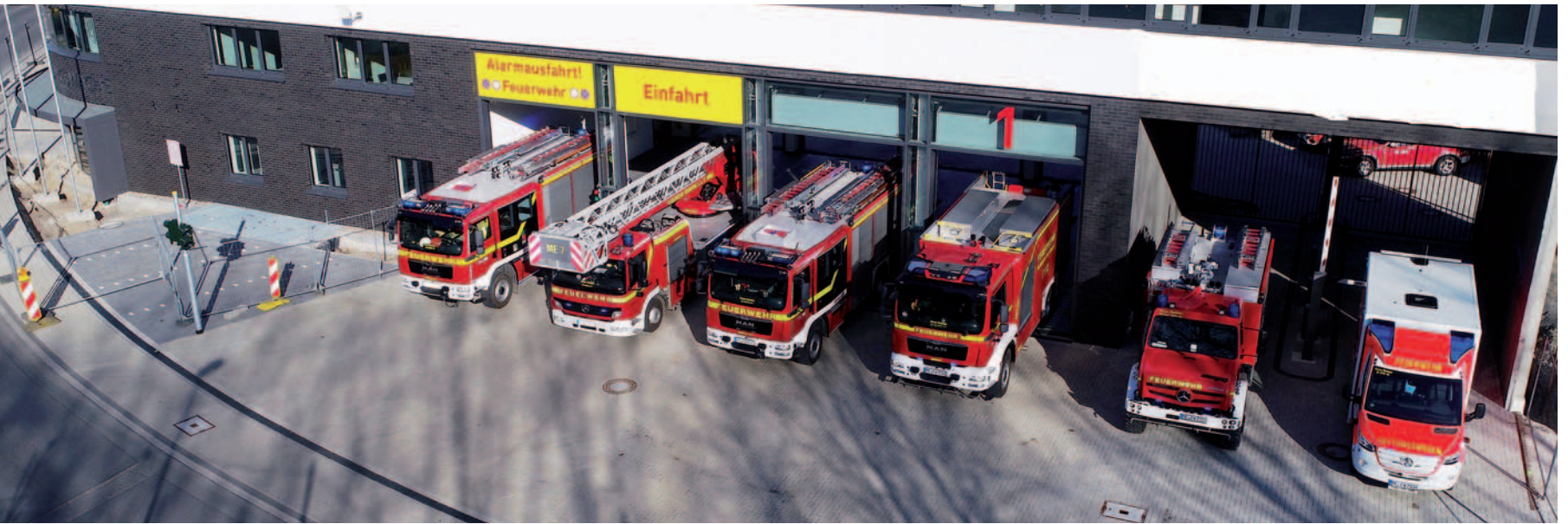
In der neuen Feuer- und Rettungswache bezog die Feuerwehr nun die notwendigsten Bereiche, unter anderem die Fahrzeughalle.
