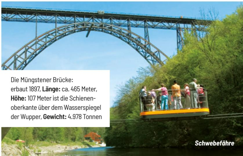
Die Müngstener Brücke: erbaut 1897, **Länge:** ca. 465 Meter, **Höhe:** 107 Meter ist die Schienenoberkante über dem Wasserspiegel der Wupper, **Gewicht:** 4.978 Tonnen
