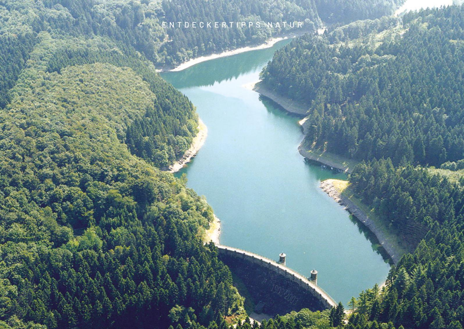
Der Pionier des deutschen Talsperrenbaus, Otto Intze aus Aachen, wurde damals beauftragt. Der hatte sich schon in der Nachbarstadt Remscheid mit dem Bau eines Wasserwerks und der Eschbachtalsperre verdient gemacht. Wichtig war ihm, dass diese Schwerlastmauern auf der Wasserseite von einem sogenannten „Intzekeil“ stabilisiert werden.
