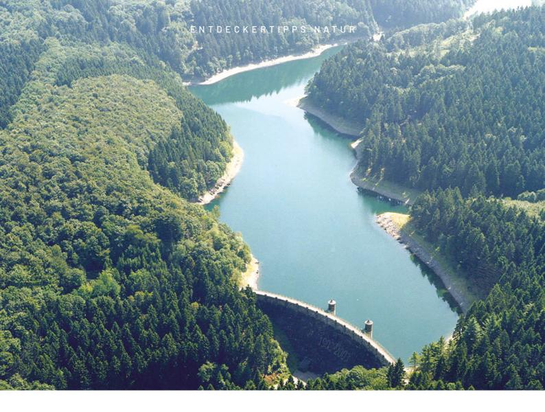
Der Pionier des deutschen Talsperrenbaus, Otto Intze aus Aachen, wurde damals beauftragt. Der hatte sich schon in der Nachbarstadt Remscheid mit dem Bau eines Wasserwerks und der Eschbachtalsperre verdient gemacht. Wichtig war ihm, dass diese Schwerlastmauern auf der Wasserseite von einem sogenannten "Intzekeil" stabilisiert werden.
