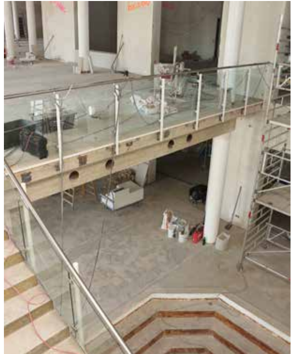
Im Juni wurden in den umzugestaltenden Räumen im Rohbauzustand zunächst die Verkabelungen installiert. Foto: A. Voss
