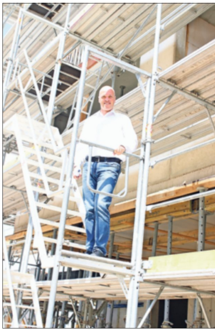
Der Bürgermeister: Auch auf der Baustelle der neuen Feuerwache zieht es nach oben. Foto: -gpm.
