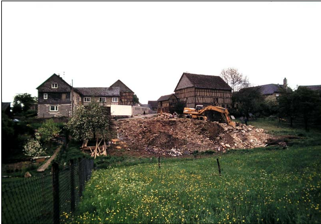
Das geplante Grundstück Pfarrgarten 17
