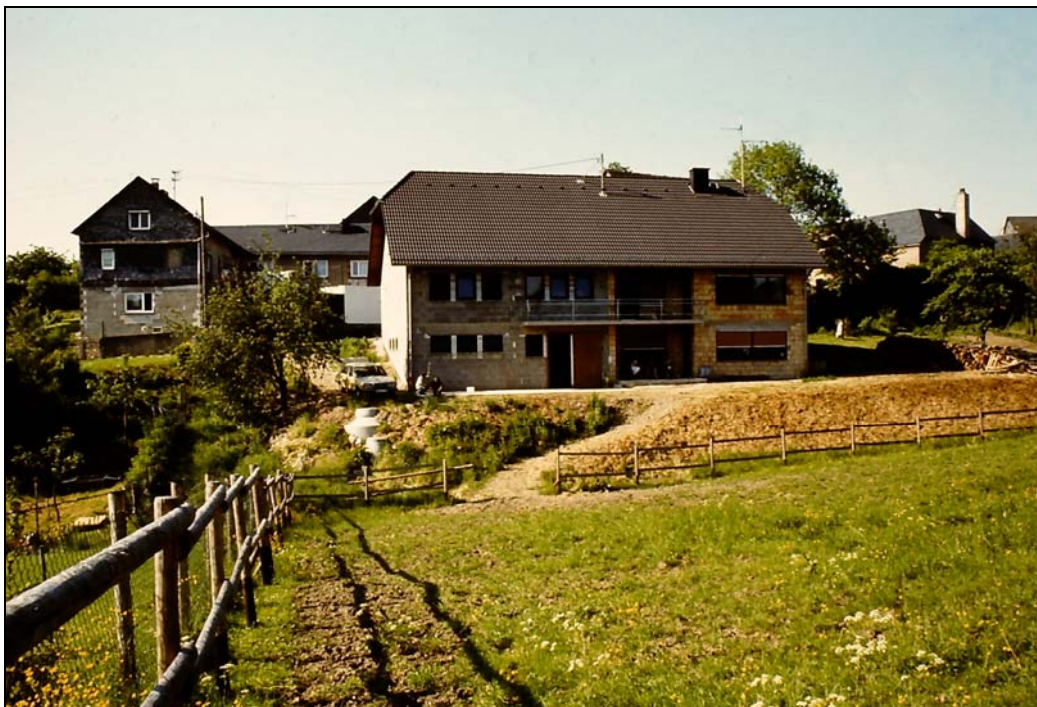
Das Grundstück nach der Bebauung
