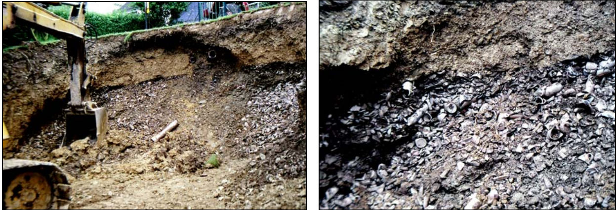
Die Baugrube gegenüber Am Pfarrgarten 8 (Parzellen 78 und 79/3)
