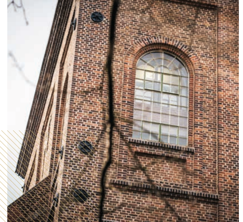
Imposantes Bauwerk. Der Malakowturm der ehemaligen Zeche Julius Philipp in Bochum-Wiemelhausen.
