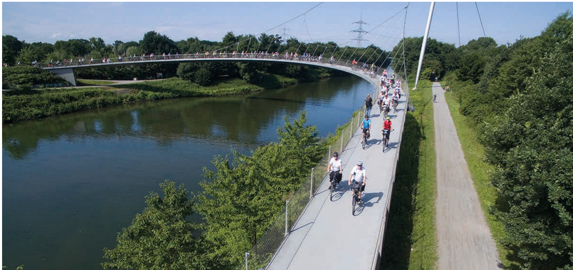
Spektakuläre Grimberger Sichel, die mit einer Spannweite von 150 Metern den Brückenschlag über den Rhein-Herne-Kanal bei Gelsenkirchen macht.
