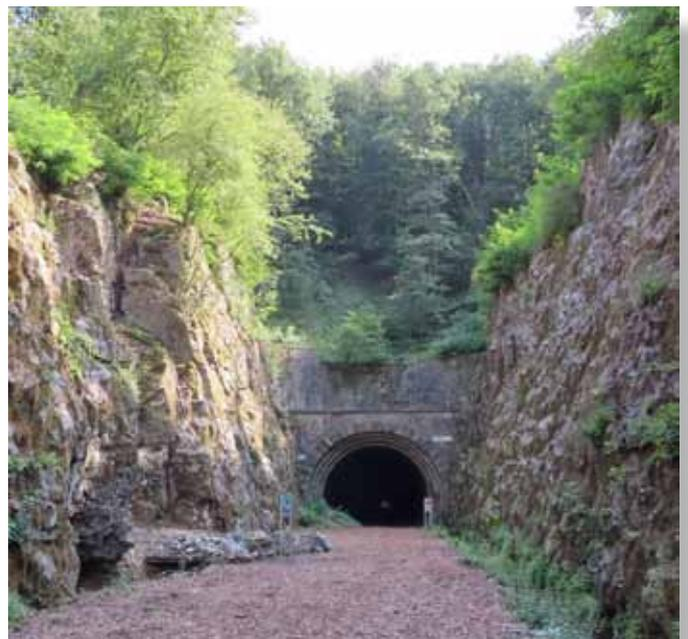
Der Bahneinschnitt nach Abschluss der Pflegemaßnahmen im Spätsommer mit freigeschnittenen Felswänden, einer angelegten Rohbodenfläche und aufgestellten Infotafeln (im Hintergrund).
