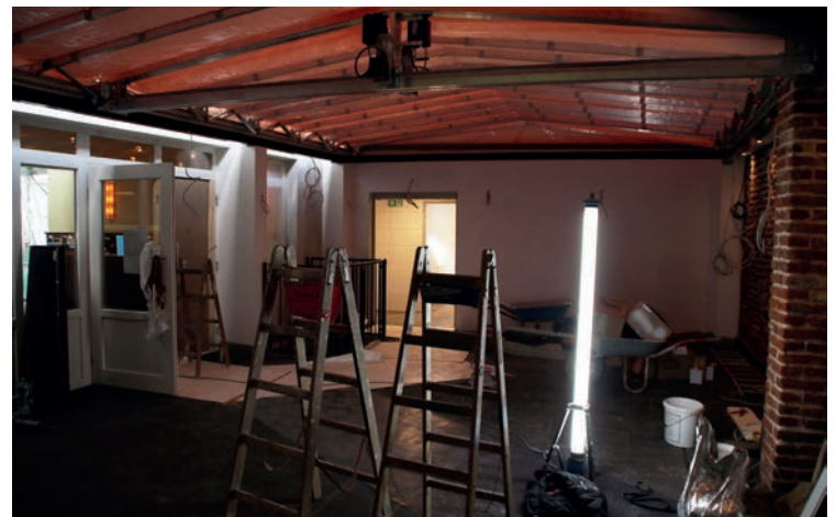
→Die freigelegten Backsteinwände geben dem neuen, hinteren Gastbereich ein besonderes Flair
