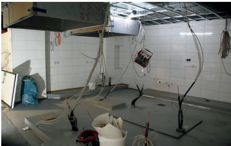
→Die Küche wird von grundauf modernisiert, inklusive neu gegossener Decke.
