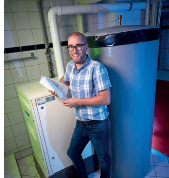
Die Brennstoffzelle für den Gebrauch im Einfamilienhaus.
