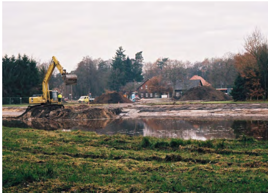
Anlage eines Stillgewässers im Rahmen eines Straßenneubaus zur frühzeitigen Wiederherstellung von Lebensraumfunktionen für Fledermäuse und Amphibien (Bild: M. Stenzel).
