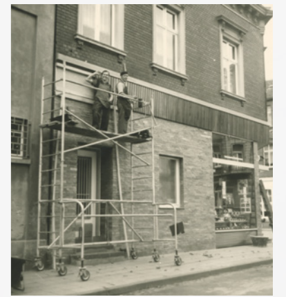
Fleißige Handwerker - die Drogerie wird 1957/58 auf Vordermann gebracht. © Ulrike Oberbach
