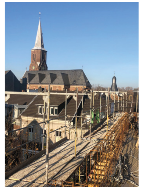
Der Blick von der Baustelle auf St. Peter und Paul kann sich sehen lassen ... © Stefan Pick
