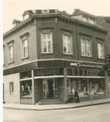
Die Drogerie Wilhelm Sommer Nachfolger nach der Renovierung um 1957/58 © Ulrike Oberbach
