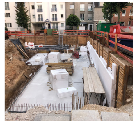
Die Schaffung des Fundaments war mit viel Aufwand verbunden. © Stefan Pick
