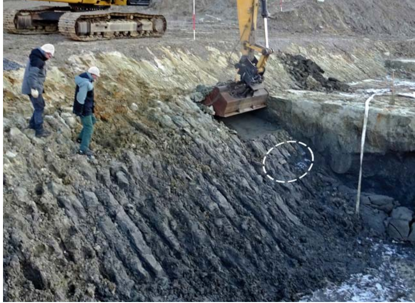
Fundstelle in der Baugrube in Ratingen
