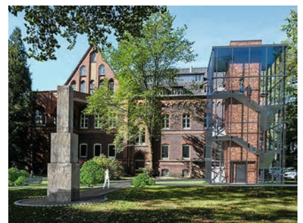
Das neue FH-Gebäude bekommt ein gläsernes Treppenhaus mit Aufzugskern.
