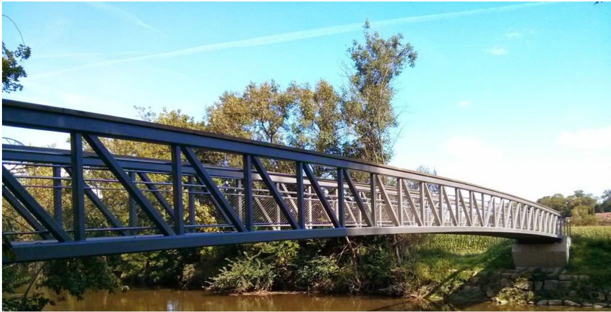
Abbildung 1-1: Brücke über die Enz bei Markgröningen
