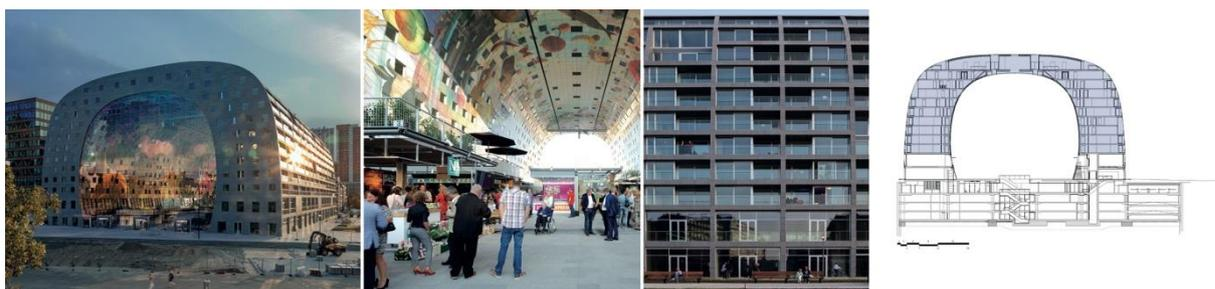
Abbildung 3-3: Markthalle in Rotterdam mit Wohnnutzung im überspannenden Rahmen | MVRDV | Rotterdam (NL) | 2014
