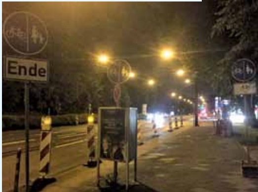
Schilderrätsel Baustelle Ulmenstr.
