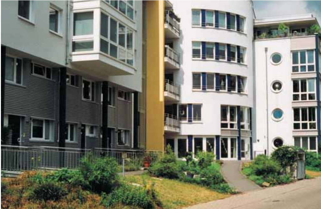
Straßenansicht mit Blick auf den Rundbau: im Erdgeschoss das Gemeinschafts-Café und im 1. Stock der Gemeinschaftsraum.
