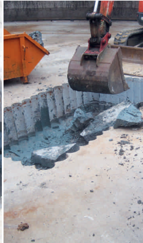
Um die Zulauf- und Rücklaufschlammleitung am Nachklärbecken der Kläranlage Volmetal sanieren zu können, musste zunächst die 75 Zentimeter dicke Bodenplatte mit Kernbohrungen ausgestanzt werden.
