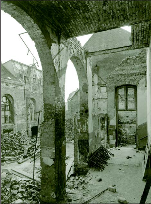
Die Kapelle des katholischen Krankenhauses wurde bei dem Angriff völlig zerstört.
