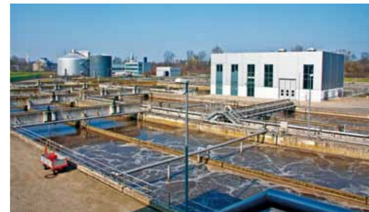
Kläranlage Lünen, © LIPPEVERBAND, Gabi Lyko
