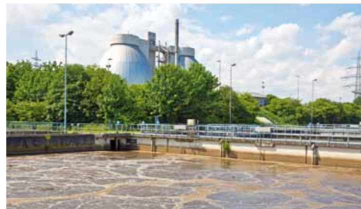
Kläranlage Dortmund Scharnhorst, © LIPPEVERBAND, Rupert Oberhäuser
