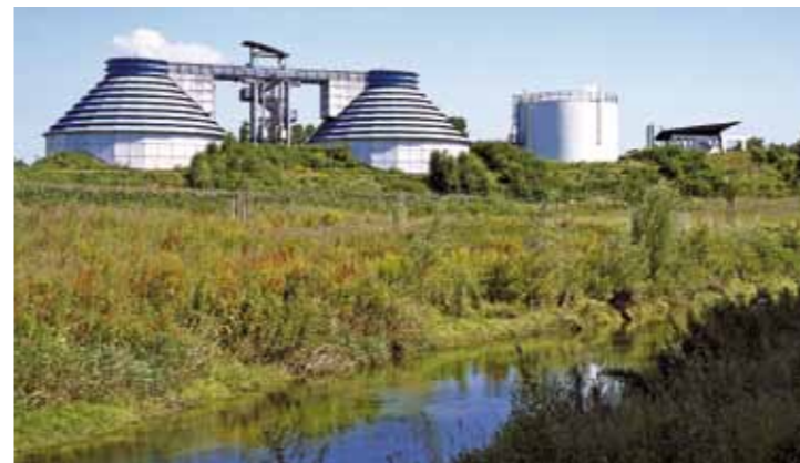
Kläranlage Kamen, © LIPPEVERBAND, Joachim Schuhmacher
