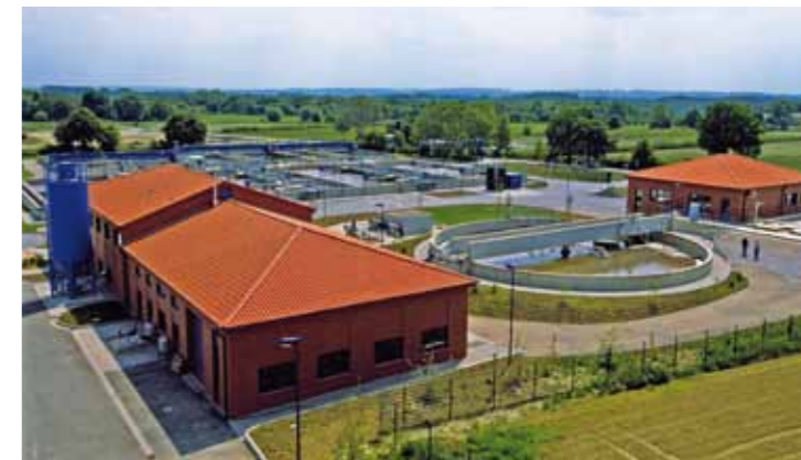
Kläranlage Bönen, © LIPPEVERBAND, Klaus Baumer
