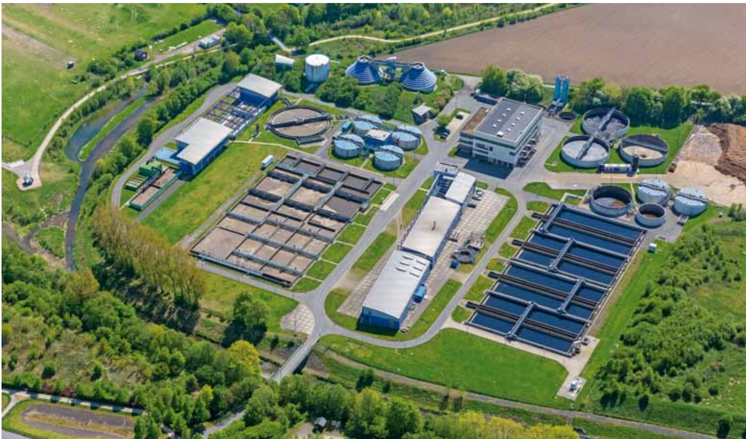
Kläranlage Kamen, © LIPPEVERBAND, Hans Blosser
