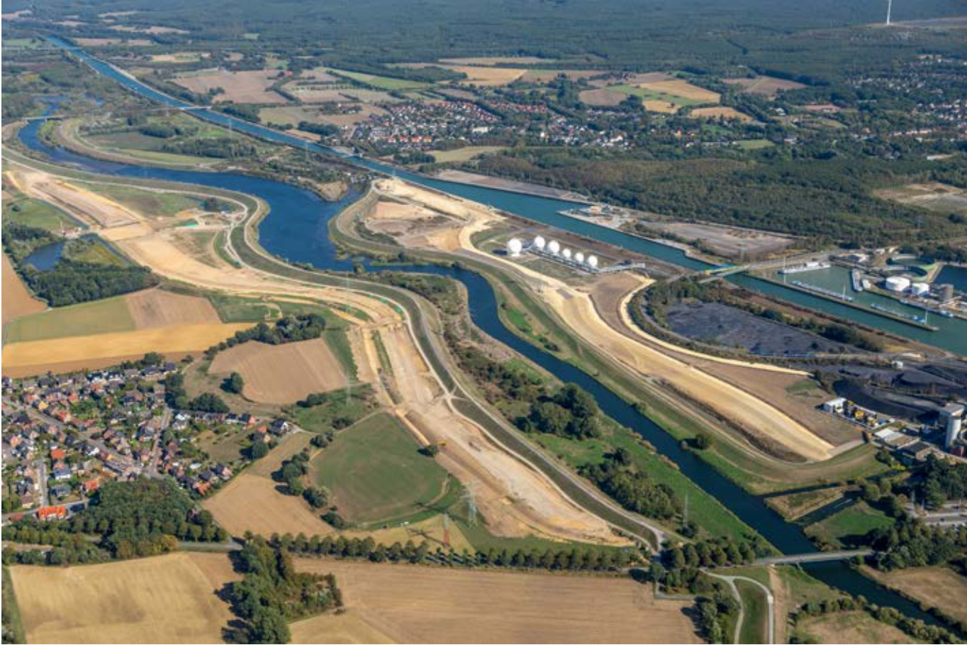
Bei Haltern-Lippamsdorf wird der neue Lippe-Deich im Hinterland der alten, steilen Deiche errichtet.
