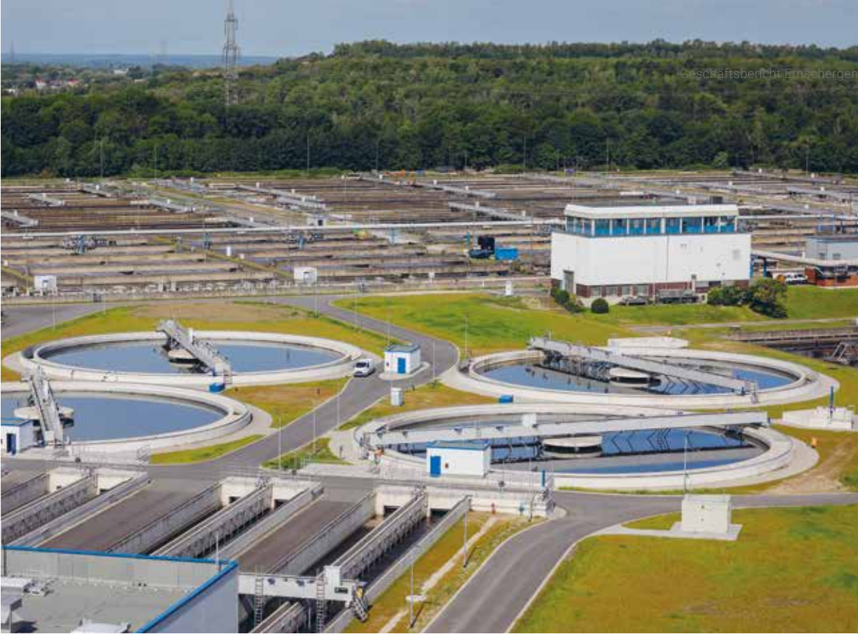
Die Kläranlage Emscher-Mündung in Dinslaken.
