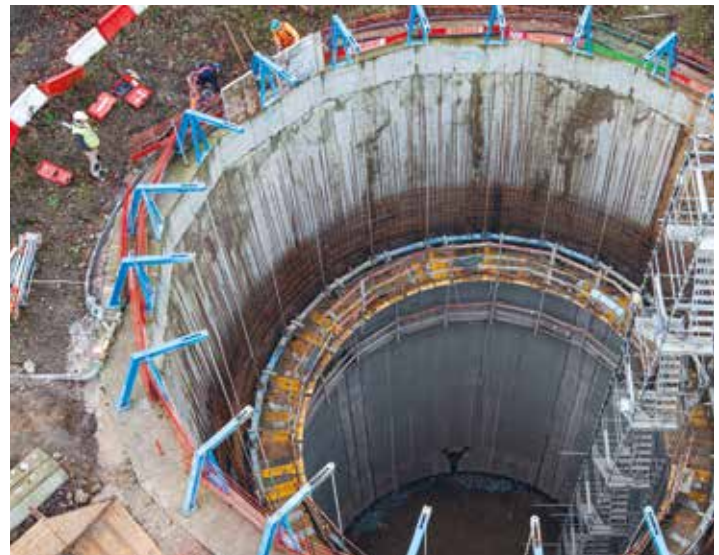
Bild rechts: Die Vortriebsbaustelle für den unterirdischen Kanal. Bild unten: Der Holzbach vor dem Umbau.
