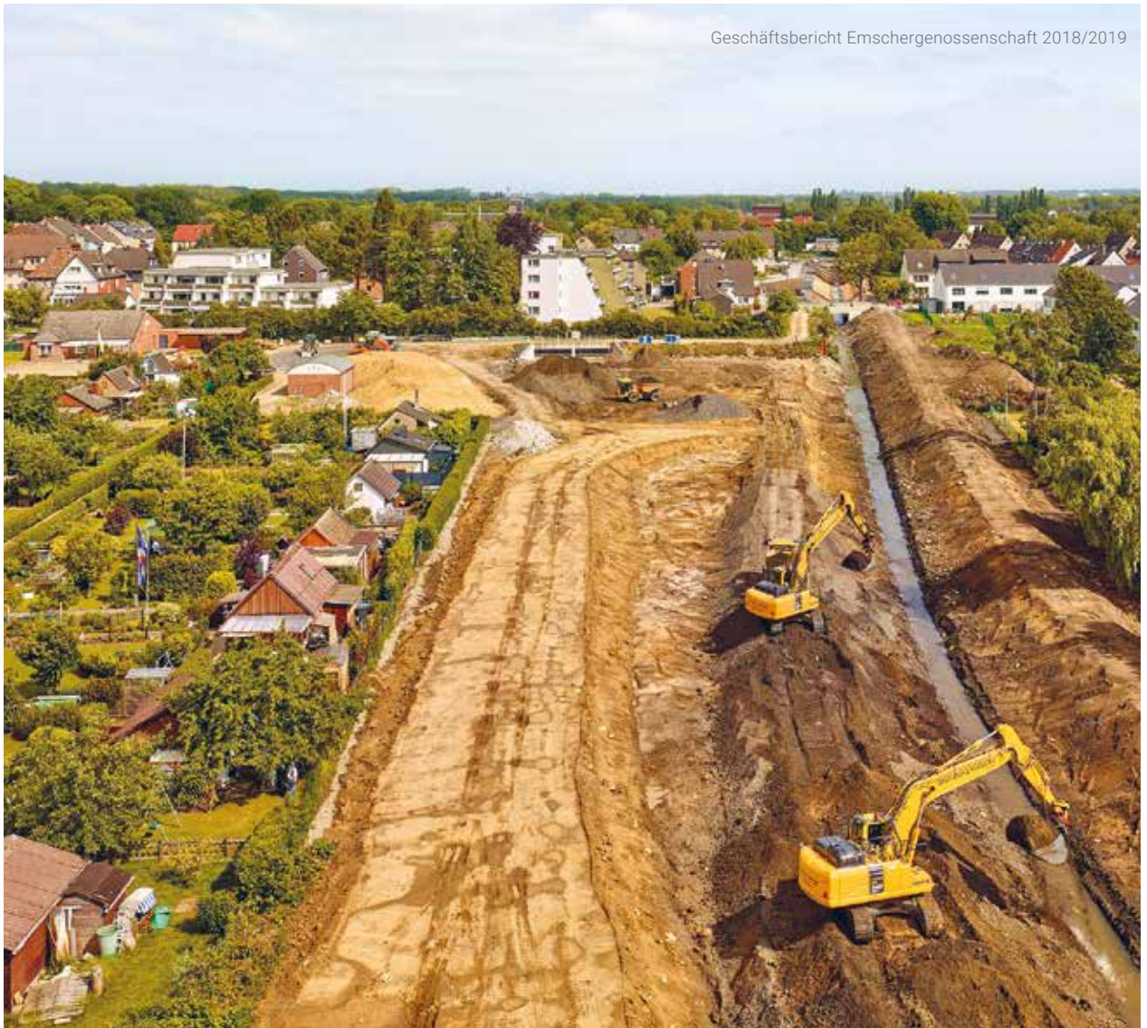
Arbeiten für die ökologische Verbesserung am Hellbach.
