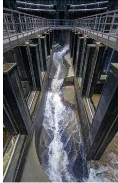
Das Pumpwerk Gelsenkirchen im Bau und nach der Inbetriebnahme.
