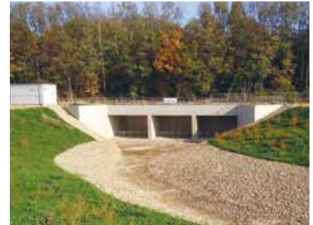
Das neue Entlastungsbauwerk am Katernberger Bach.
