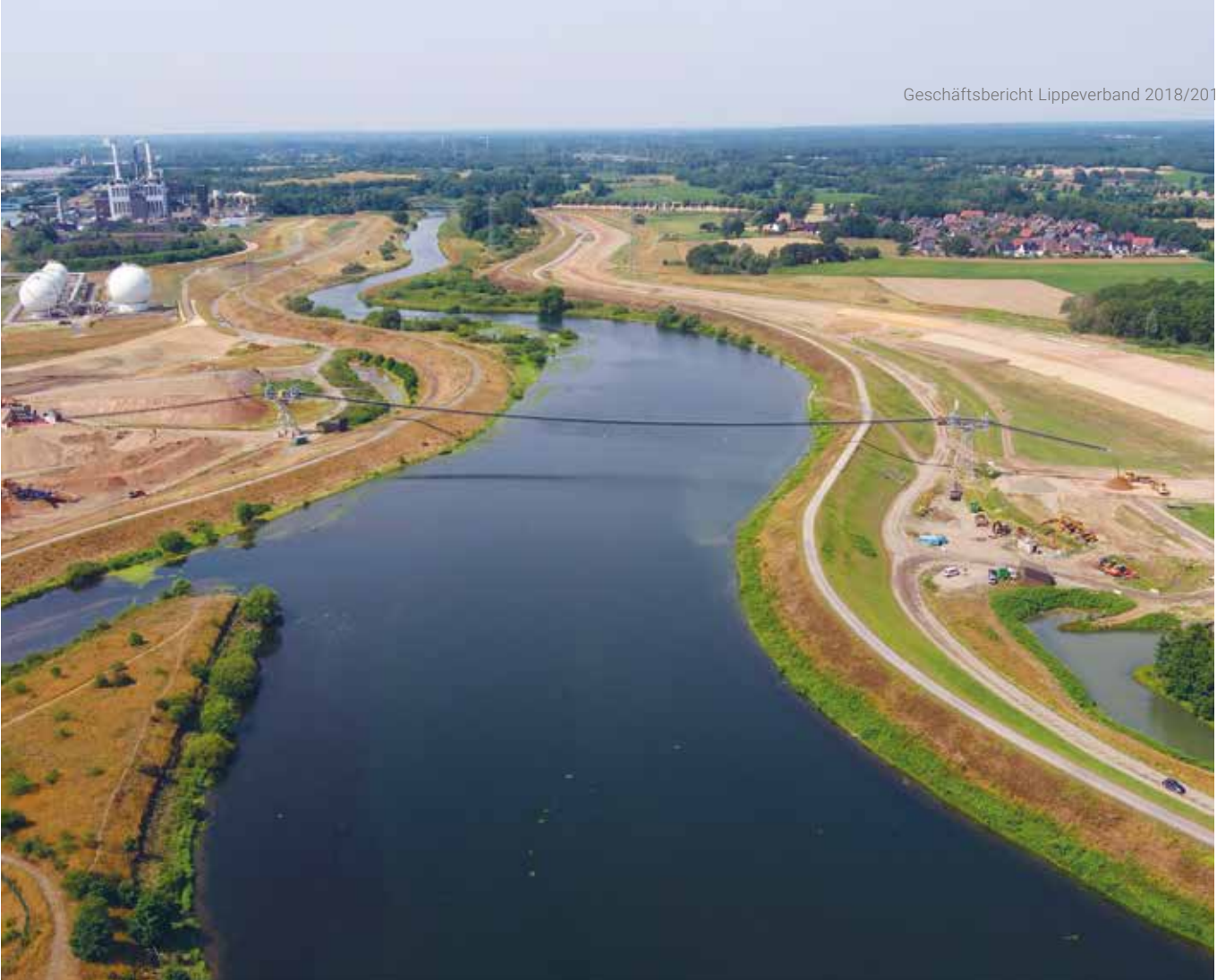
Das Deichbau-Projekt HaLiMa.
