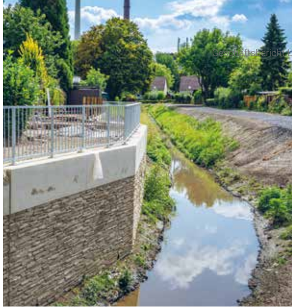
Bild rechts: Der "neue" Dümmerbach. Bild unten: Der Dümmerbach vor den Baumaßnahmen.
