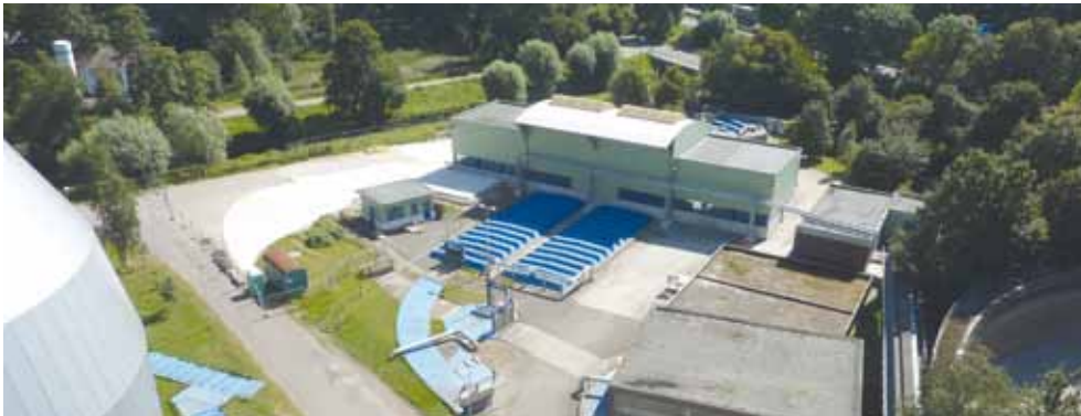
Blick auf den aktuellen Zulaufbereich
