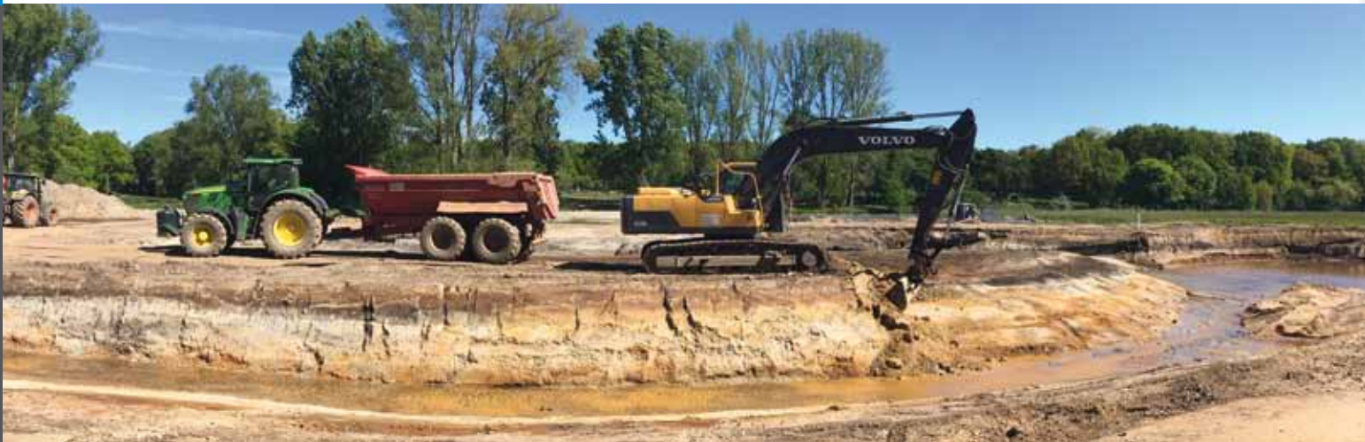
Wasserbauerinnen und Wasserbauer des Niersverbandes bei der Umsetzung der Maßnahme in Kessel
