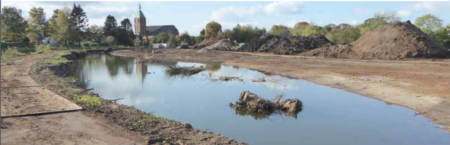
Gewässermaßnahme am Tierpark in Weeze
