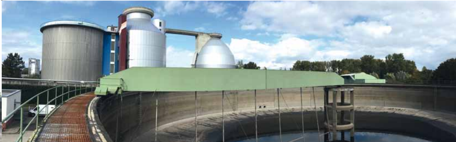
Altes Regenüberlaufbecken 2 im Vordergrund
