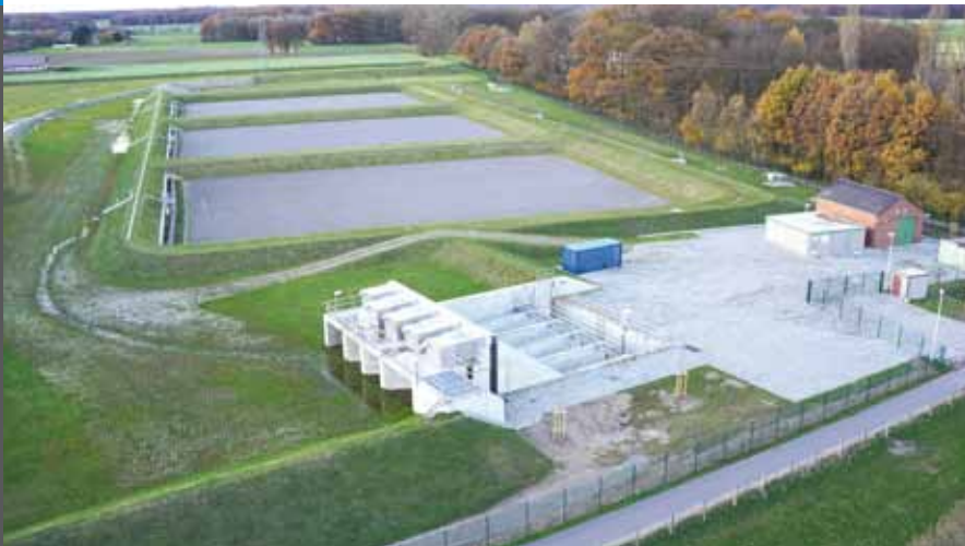
Retentionsbodenfilter an der Dülkener Nette...
