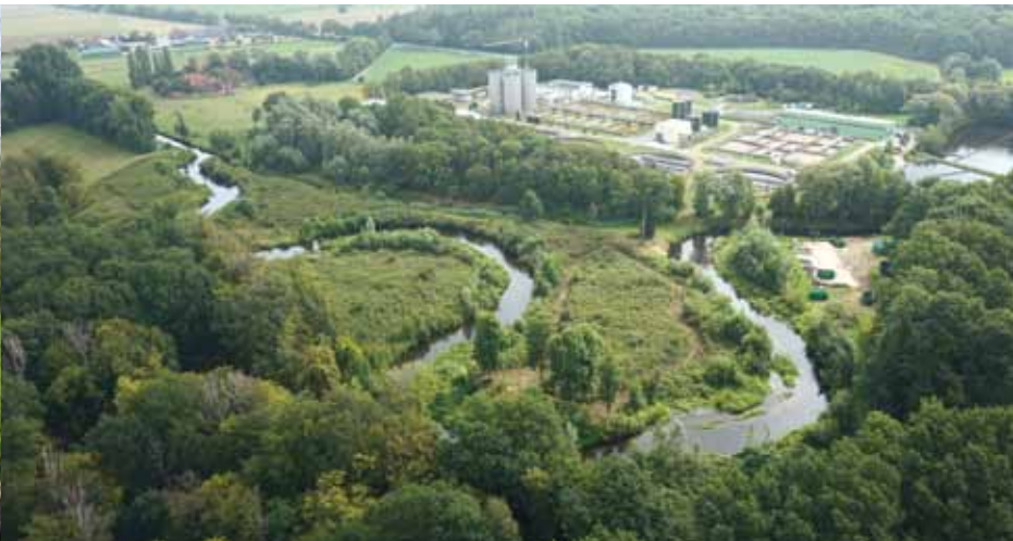
Renaturierte Niers an der Kläranlage Geldern
