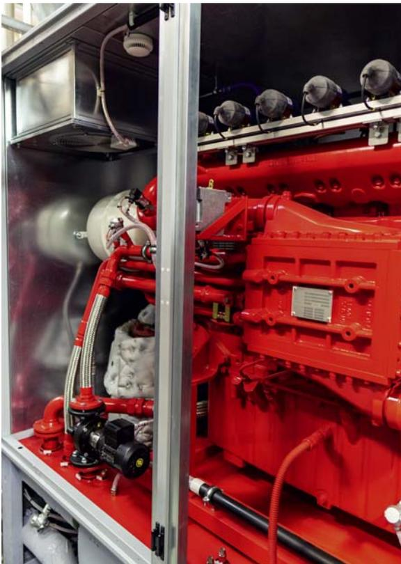
rungen an Abgasemissionen Rechnung. Die neuen Module erzeugen vergleichsweise mehr elektrische Energie als Wärmeenergie. Diese kann auf der Anlage flexibler eingesetzt werden. Aber auch Wärmeenergie wird auf der Anlage benötigt, denn damit werden Faulbehälter und Betriebsgebäude beheizt.
