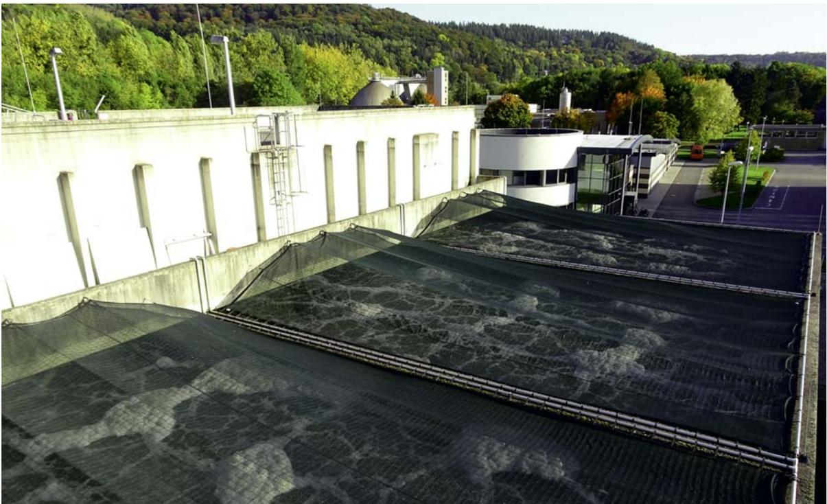
Für die Alzette als dem natürlichen Vorfluter der Kläranlage Beggen sind aufgrund der geringen Leistungsfähigkeit sehr niedrige Einleitungswerte von unter  $1 \text{ mg NH}_4\text{-N/l}$  bzw.  $8 \text{ mg N}_{\text{ges}}/\text{l}$  gefordert. Diese können mit einer konventionellen statischen Bemessung nicht nachgewiesen werden und sollen daher über eine dynamische Simulation der Gesamtanlage durch die WiW mbH bestätigt werden.
