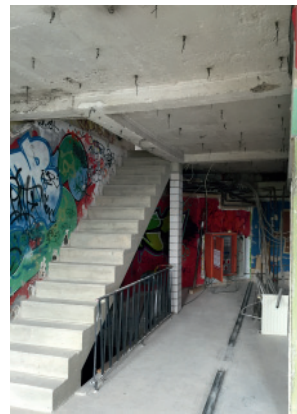
Abrissarbeiten sind soweit abgeschlossen Foto: Stadt Solingen
