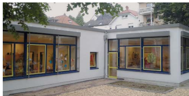
Während es am Außengelände noch einiges zu tun gibt, erstrahlt das Außengebäude schon in neuem Glanz Foto: A. Bellmann
