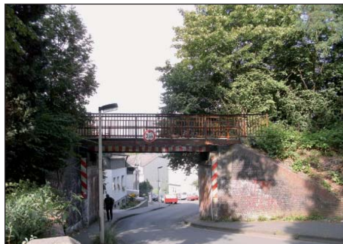
Brücke an der Klauberger Straße
