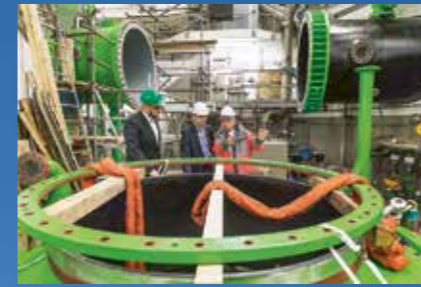
Rund 25 Millionen Euro wurden in das Pumpspeicherkraftwerk Rönkhausen investiert.
