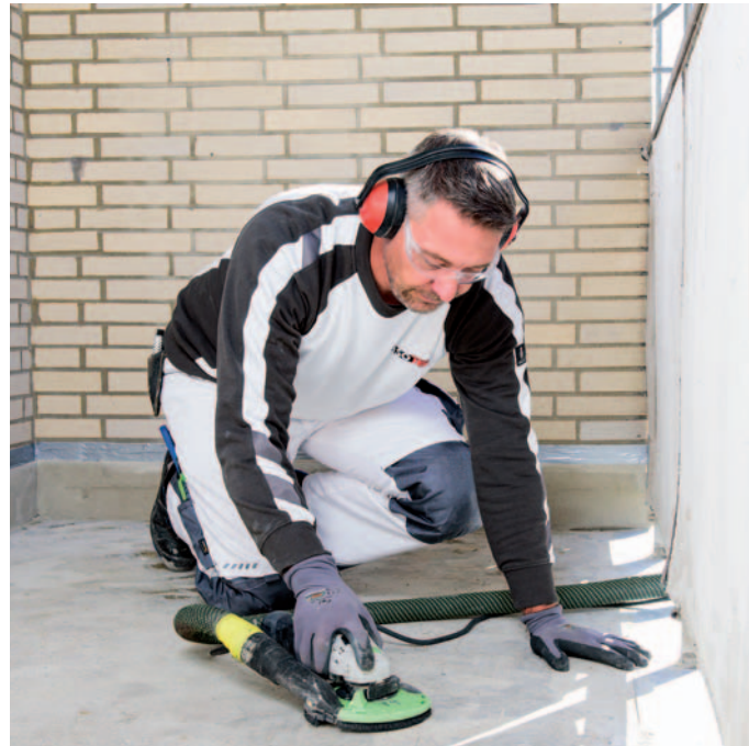
Nach der Balkonsanierung lässt sich der Balkon wieder voll genießen – auch im Winter. Foto: ISOTEC GmbH/Marcel Kluge
