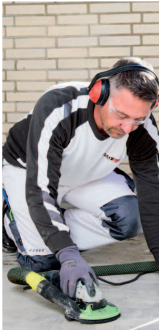
Nach der Balkonsanierung lässt sich der Balkon wieder voll genießen – auch im Winter.
