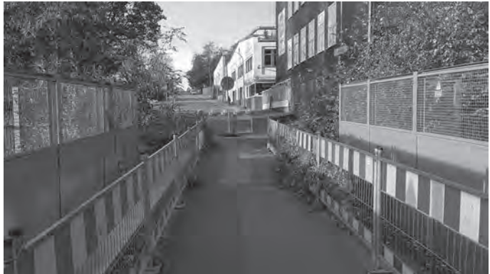
Verschoben: Der Neubau der Brücke Kirchhofstraße ist im städtischen Etat nun nicht mehr vor 2024 vorgesehen.
