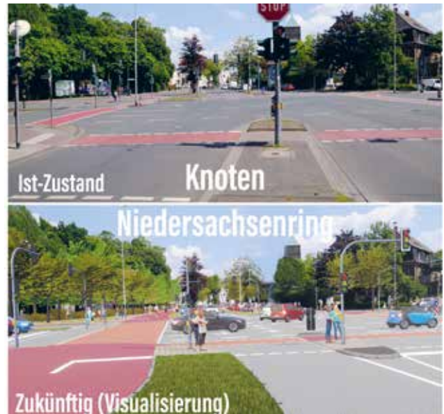
Die Querung des Niedersachsenrings im Ist-Zustand und mit zukünftiger Veloroute. Fotos: Stadt Münster
