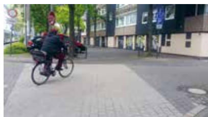
Aufpflasterung Jahnstraße. Foto: Stadt Köln
