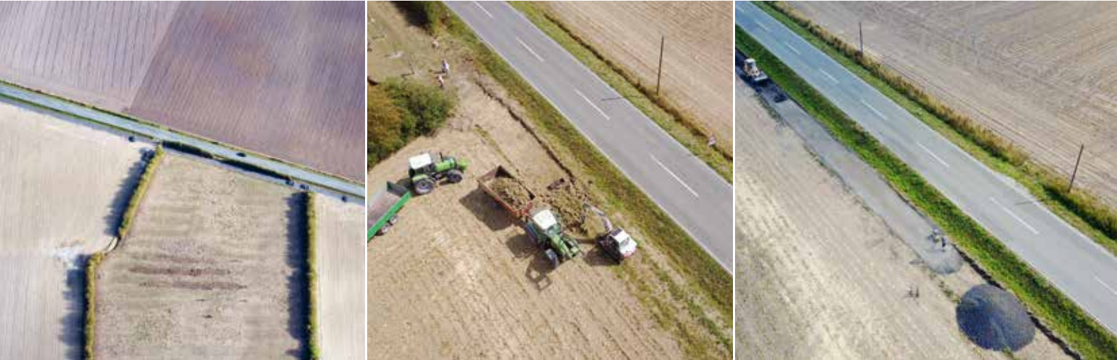
In der Gemeinde Albersloh haben Bürger eine Radweg-Lücke mit Mitteln aus dem Bürgerradwege-Programm geschlossen. Fotos: Straßen.NRW/Norbert Piontek
