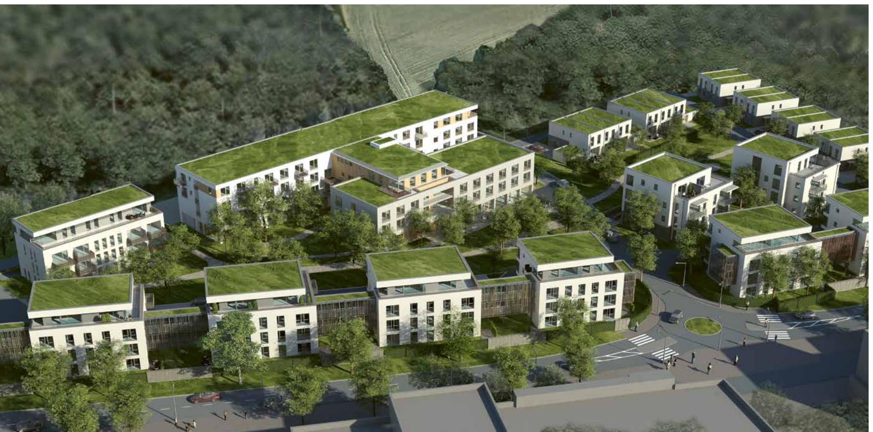
An der Nievenheimer Straße in Norf entsteht ein lebendiges Quartier für alle Generationen mit verschiedenen Wohnformen.
