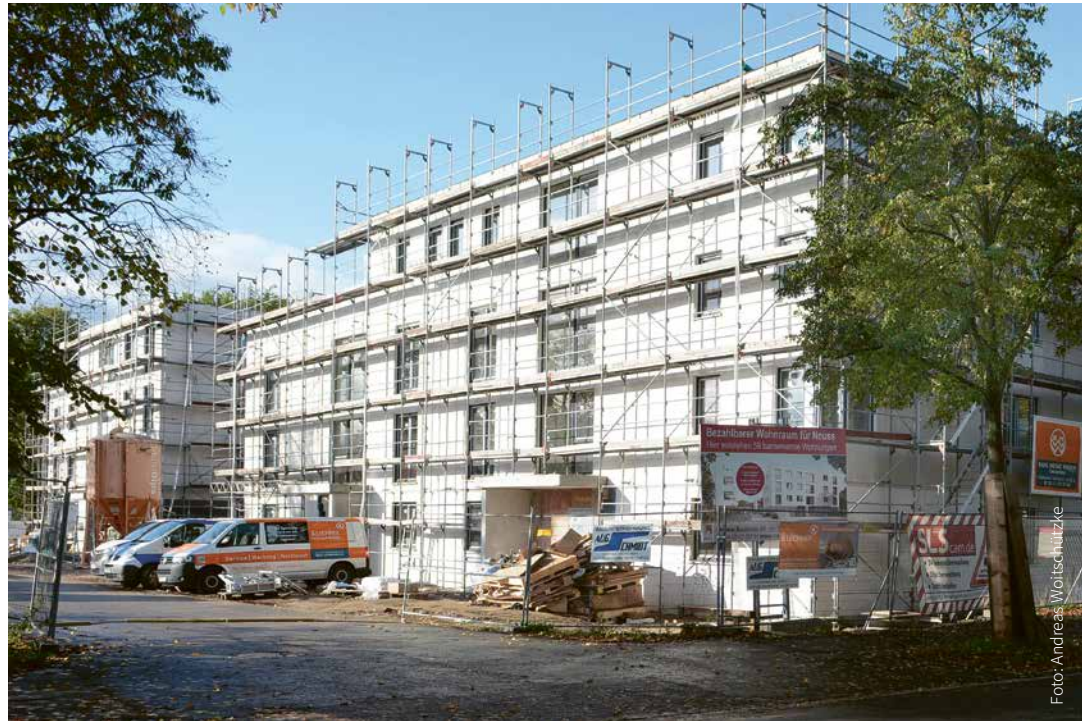
Hier entstehen an der Nordkanalallee 59 Mietwohnungen.
