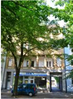
Die Straßenfont des Hauses Dreikönigenstraße 8 heute.
