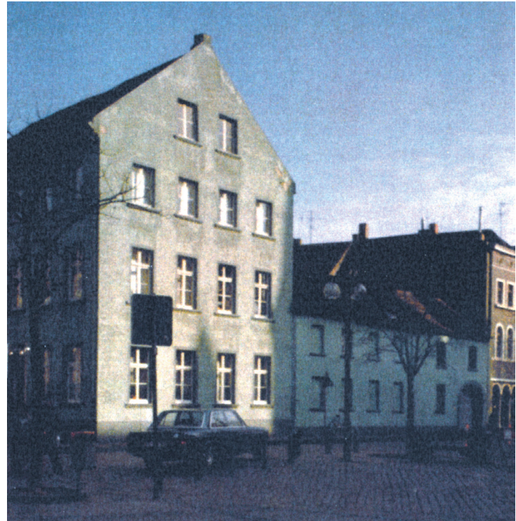
Das Kallenhaus vor der Restaurierung und vor dem Abriss des Seitenflügels
