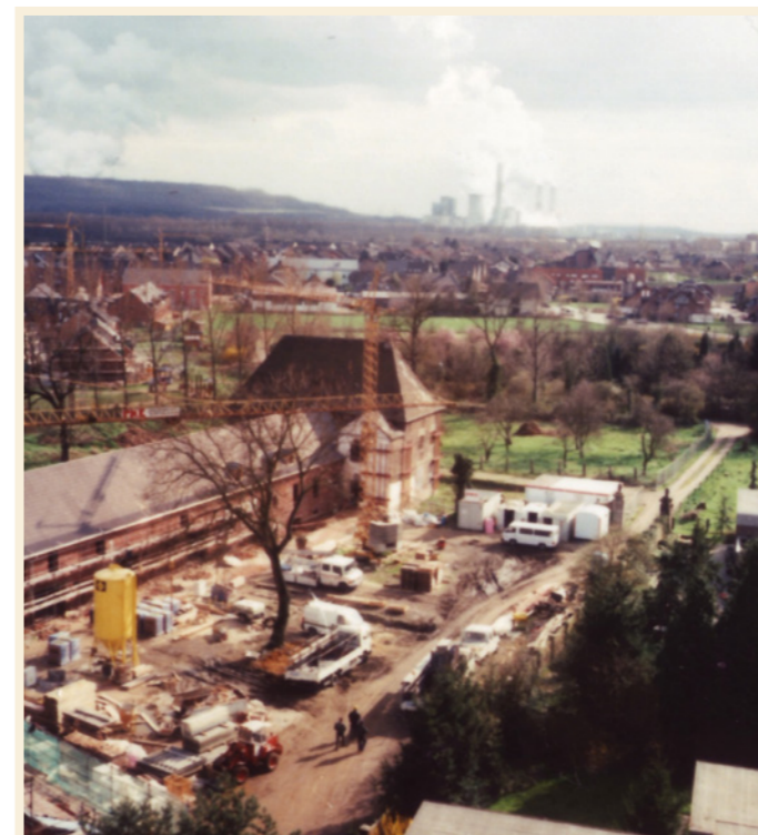
Die Großbaustelle „Elsener Haus“ am 19.03.1998
