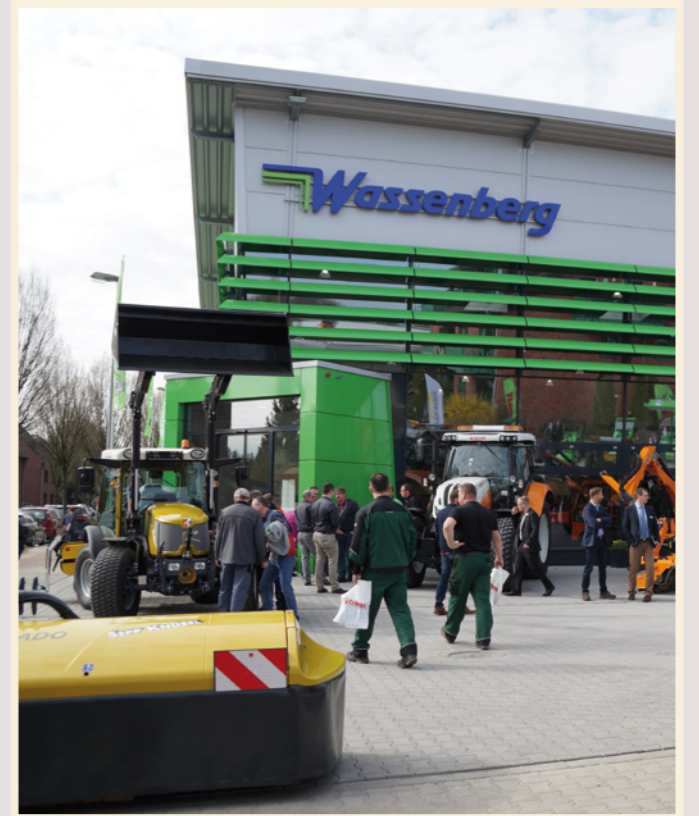
Das neue Gebäude an der Von-Goldammer-Straße kann sich sehen lassen.
