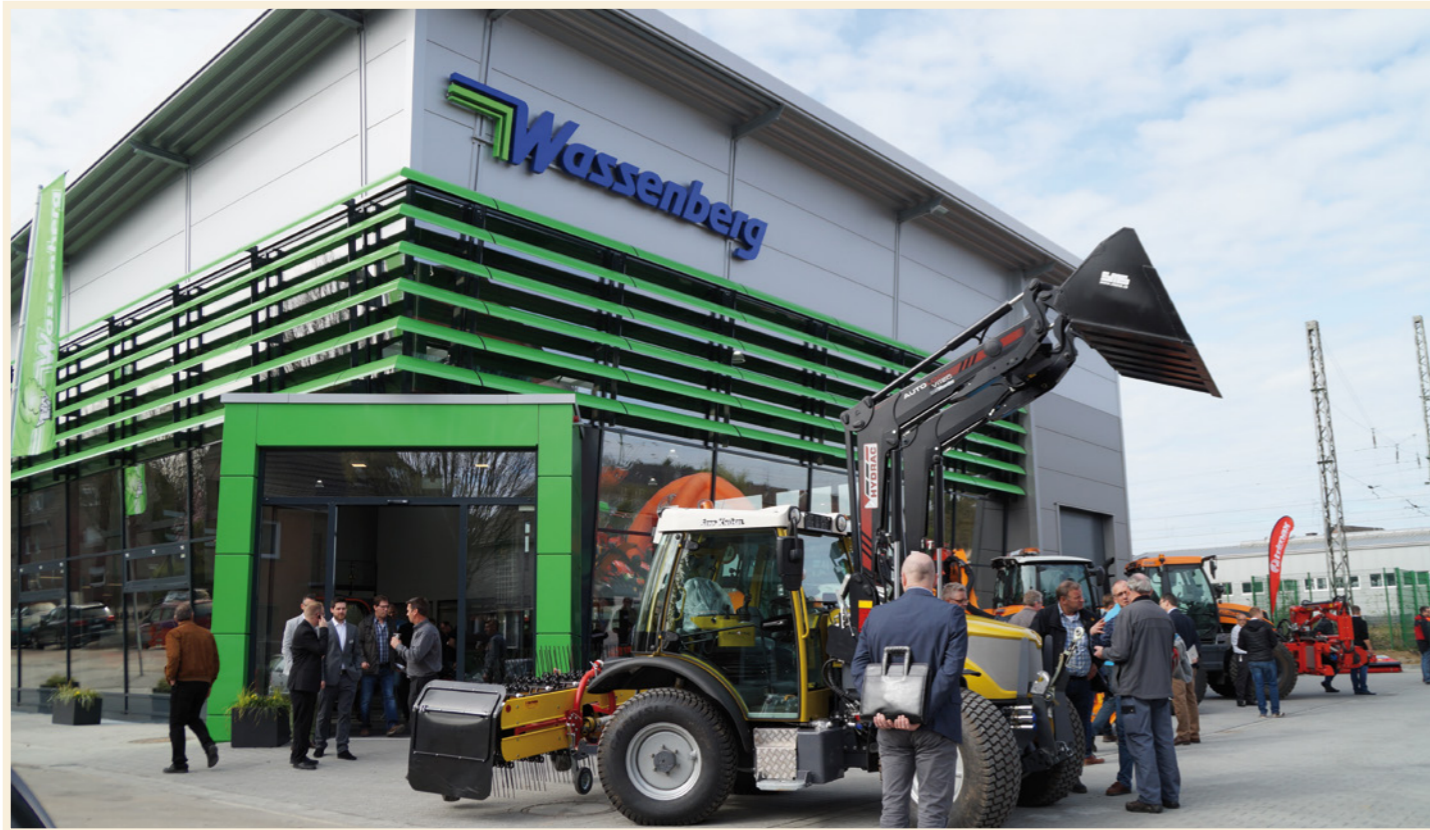
Feierliche Eröffnung des Neubaus auf der Von-Goldammer-Straße in Grevenbroich im März 2017.
