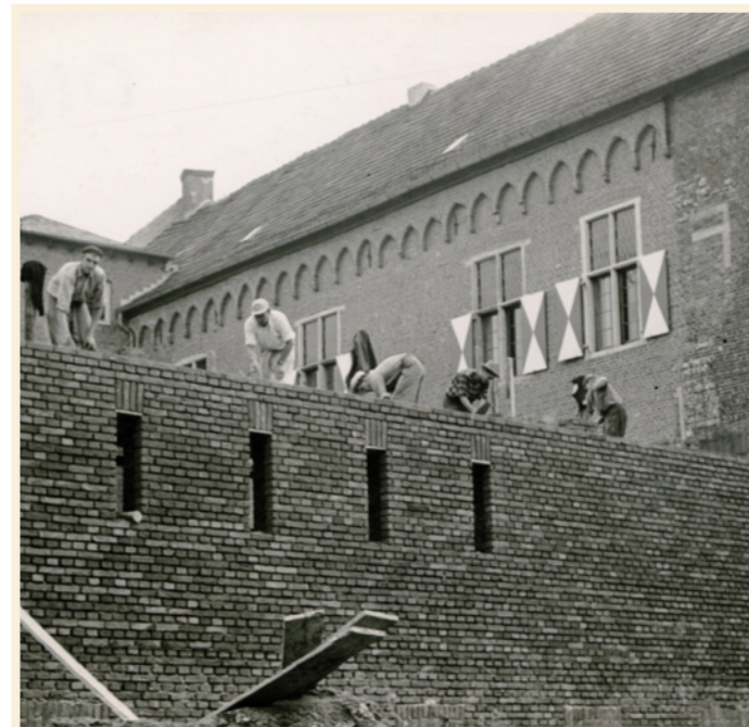
Fleißige Handwerker während der Umbauphase 1958/59.
