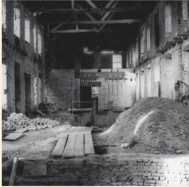
Entkernter Ostflügel während der Sanierung in den 1960er Jahren © Rita Krawinkel
