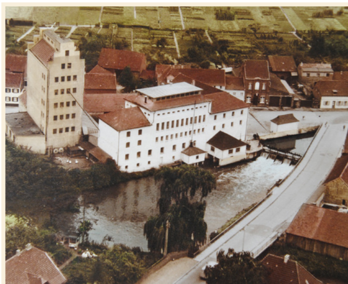
Luftaufnahme der Untermühle nach der Brandsanierung © Familie Drees
