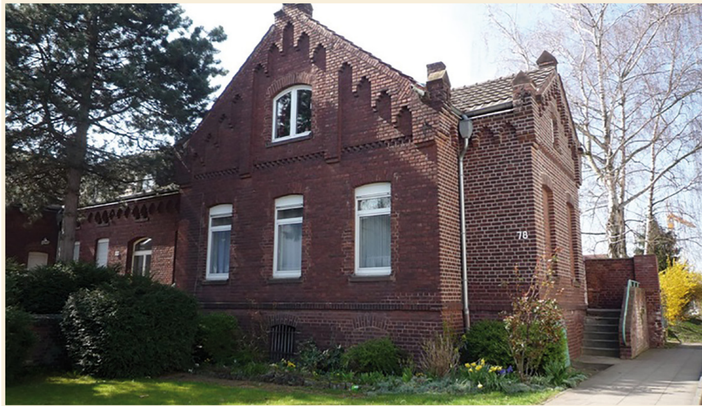
So friedlich lag das ehem. Gefängnis - nun als Mehrfamilienhaus genutzt - bis zu seinem Abriss 2012 an der Montanusstraße © Christel Onkelbach-Rheydt
