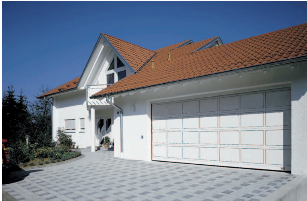
Auch bei der Garagensanierung sollte man auf Fachleute setzen.
