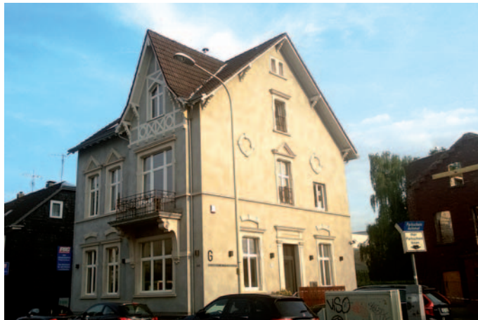
Auch das Gebäudeensemble Walder Straße 24/24a ist in das Programm eingebunden. Fotos (2): Frank Straub
