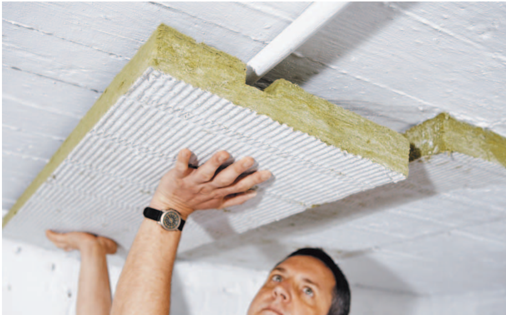
Die Dämmung der Kellerdecke ist eine effektive Maßnahme zur Energieeinsparung.
