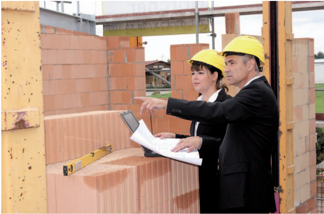
Bei der Bauabnahme kann sich Aufmerksamkeit auszahlen.
